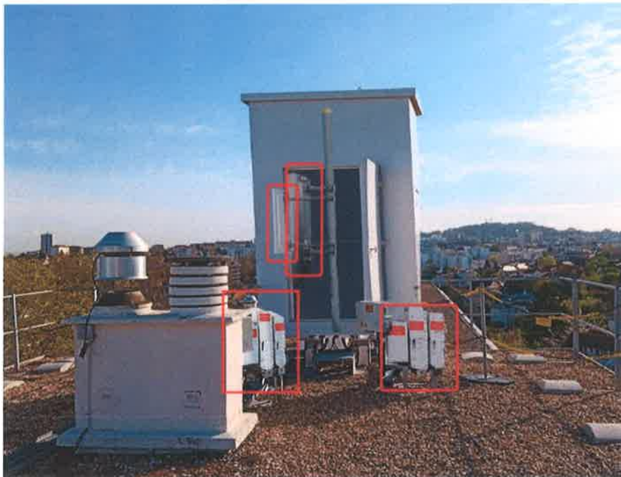
Vue de la terrasse S0 après travaux
