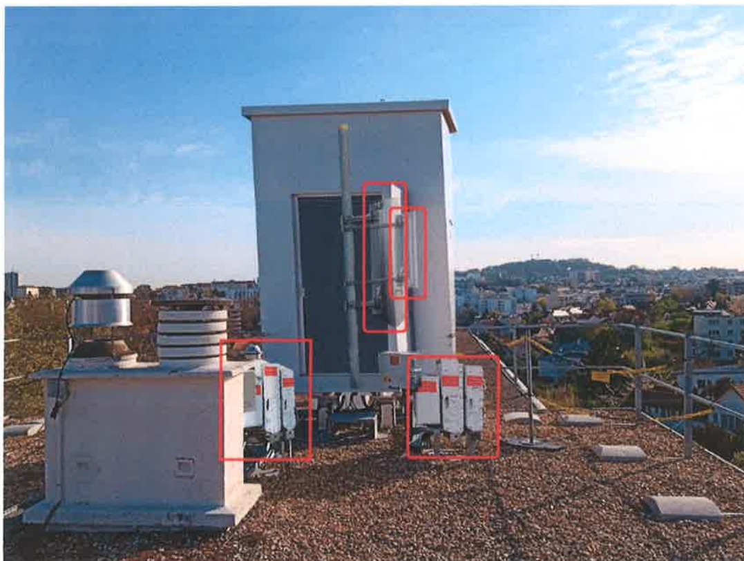
Vue de la terrasse S1 après travaux
