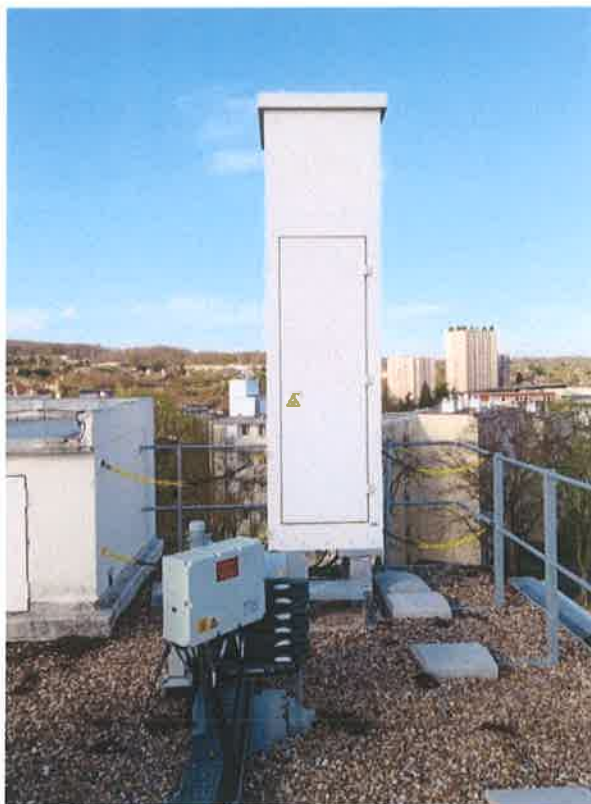
Vue de la terrasse S2 avant travaux
