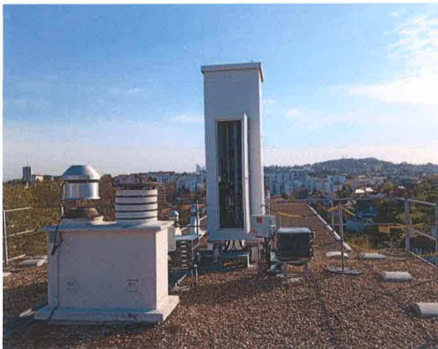
Vue de la terrasse S0 avant travaux
