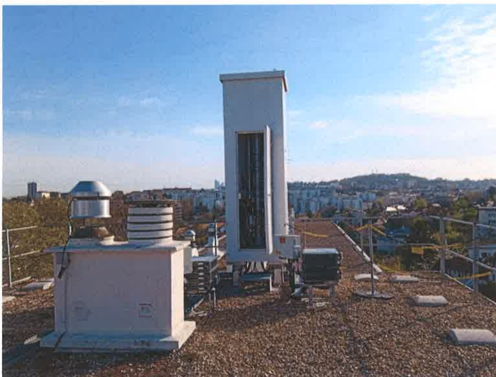
Vue de la terrasse S1 avant travaux
